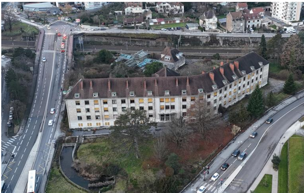
L'ancien jardin botanique a une emprise de deux hectares. La moitié sera dévolue à l'aménagement d'espaces verts. Photo Patrice Boucherat
